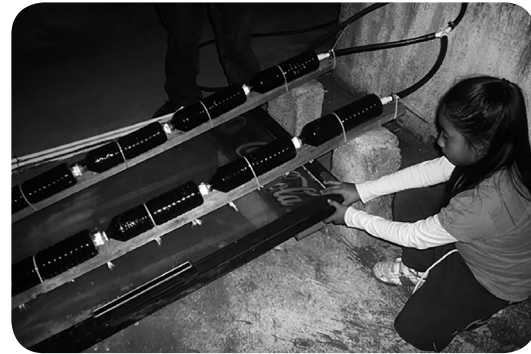
La estudiante instala el calentador en la azotea de su casa.
